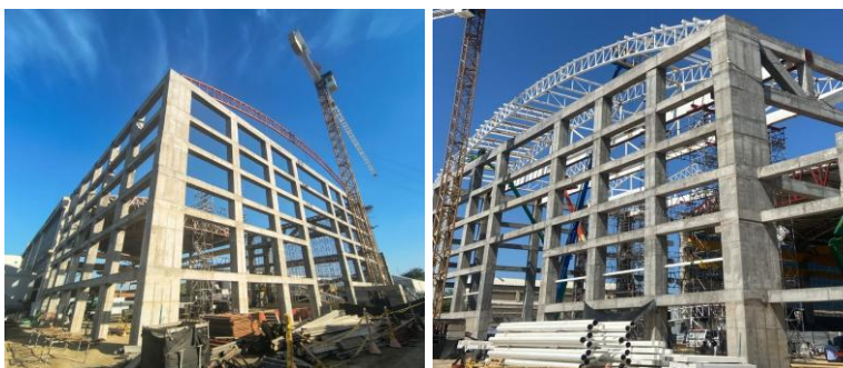
Ilustración 60. Avance en la Construcción Extensión LP2
