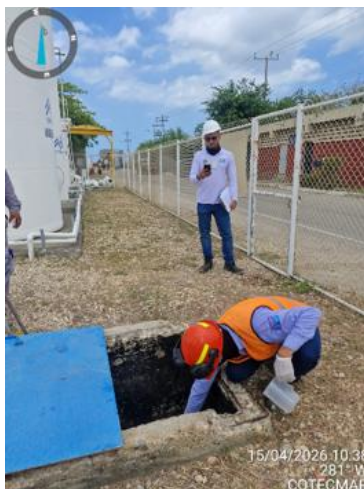
Ilustración 80. Acompañamiento del EPA al Monitoreo de la calidad de agua – abril/26
