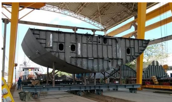
Ilustración 19. Traslado primer bloque de la Fragata colombiana a centro de la línea de producción No. 2
