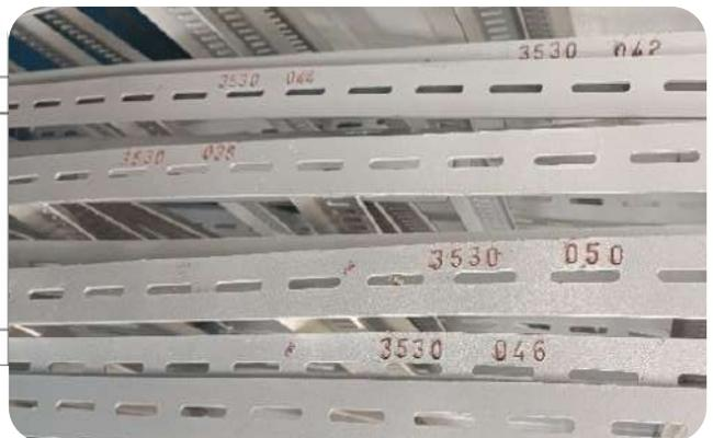
Mecanismo seguro para marcación permanente en bandejas eléctricas.
