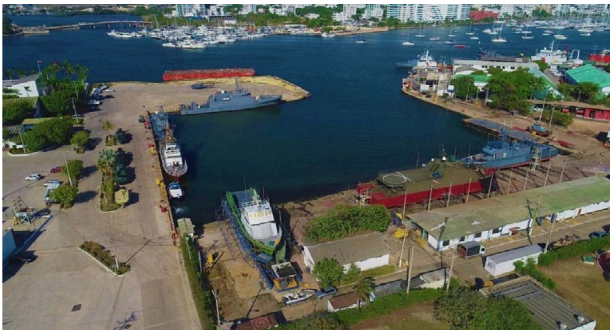
Ilustración 25- Mantenimiento Unidades - Varadero Planta Bocagrande
