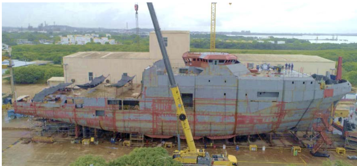
Ilustración 5 Buque de Investigación científico Marina - Erección bloques superestructura Dic/21
