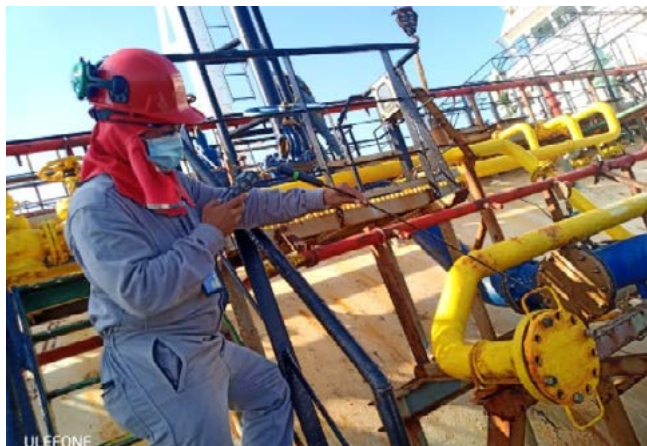
Ilustración 58 - Trabajos control de atmosferas en un buque tipo gasero atendido por COTECMAR
