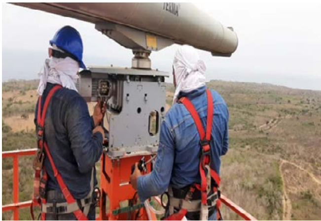
Ilustración 64 - Mantenimiento, configuración y reparación de SICTVM
