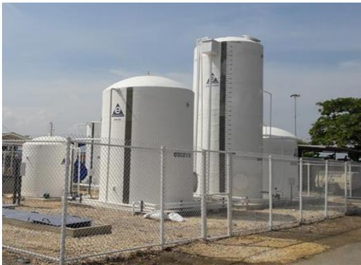
Ilustración 71. Planta de tratamiento de aguas residuales capacidad 1,12 LPS
