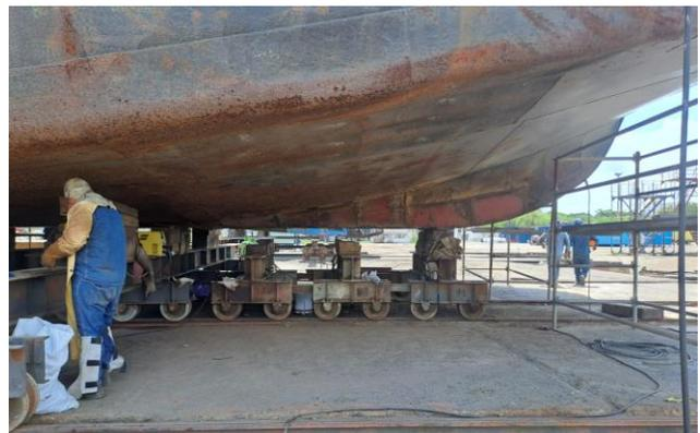
Cambio de acero en casco, fondo, espejo de popa, quillón de proa y popa; repotenciación de cuarto máquinas para instalación de motores principales; mantenimiento componentes sistema de propulsión
