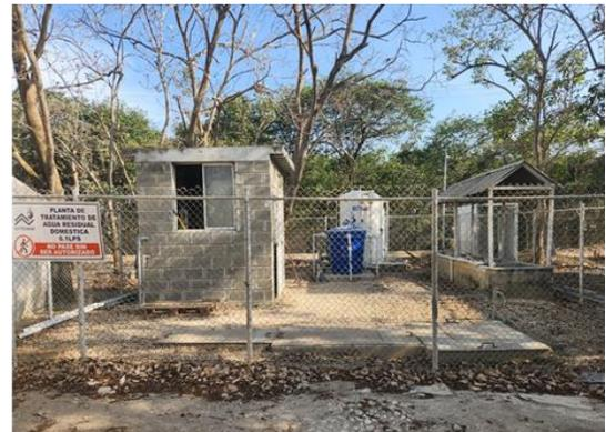
Ilustración 72. Planta de tratamiento de aguas residuales capacidad 0,12 LPS
