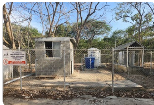
Ilustración 90 Planta de tratamiento de aguas residuales capacidad 0,12 LPS
