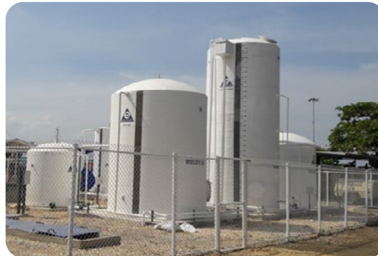
Ilustración 90 Planta de tratamiento de aguas residuales capacidad 0,12 LPS
