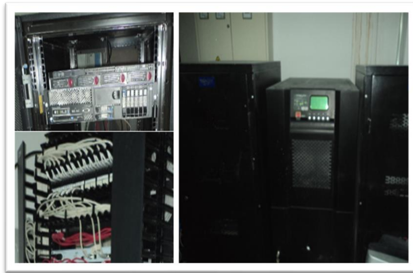
Figura 8 - Cableado y Corriente Regulada
