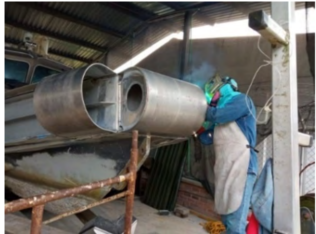
Ilustración 59. Mejora diseño defensa estructural embarcaciones de aluminio
