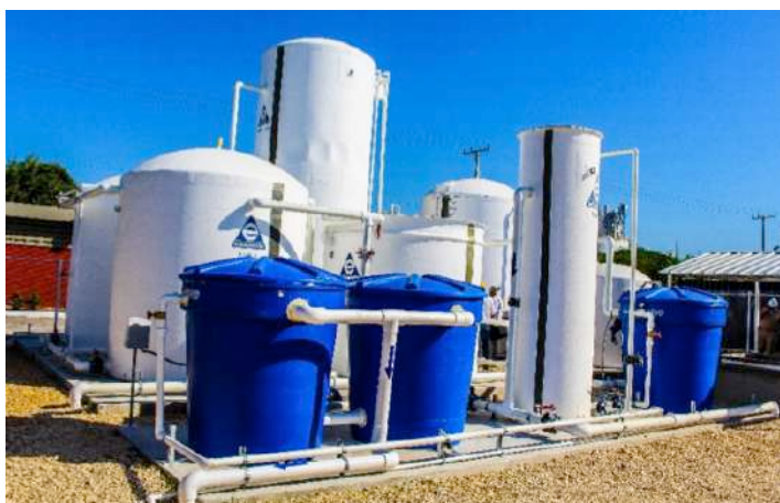
Ilustración 26. Planta de tratamiento de aguas residuales domesticas COTECMAR
