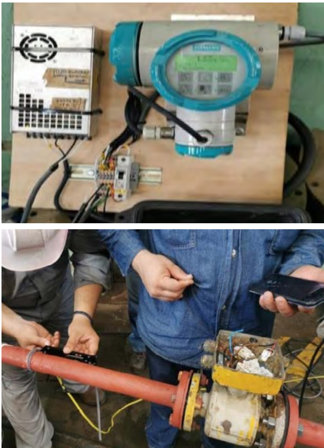
Ilustración 61 - Comparación del flujo con patrón y montaje del sensor de flujo en la ARC "Caldas".
