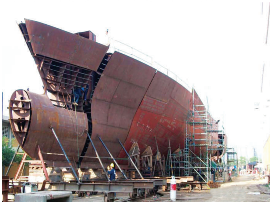
Imagen 73. Patrullero de Zona Económica Exclusiva (Offshore Patrol Vessel – OPV) Etapa de Construcción
