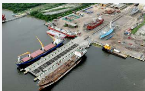
Imagen 23. Fotografía Aérea del Sincroelevador de COTECMAR
